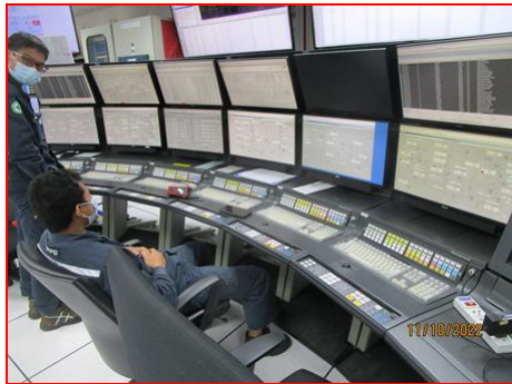
ภาพที่ 2.2-44 ระบบ Distributed Control System
