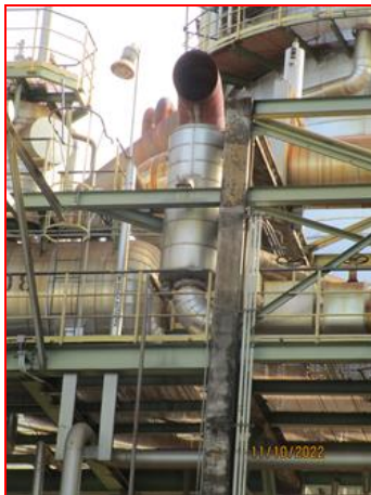
ภาพที่ 2.2-20 การติดตั้งอุปกรณ์ลดระดับเสียง (Silencer) (ADU)
