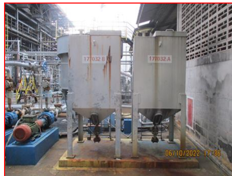
ภาพที่ 2.2-30 Slop Oil Tank เพื่อรวมคราบน้ำมัน จากบ่อพักน้ำเสีย CPI/IAF
