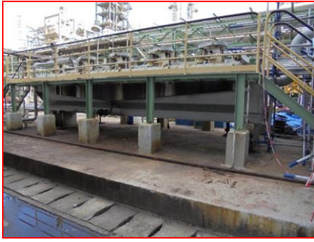
ภาพที่ 2.2-8 บ่อพักน้ำเสีย IAF (ADU)
