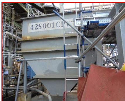
ภาพที่ 2.2-6 บ่อพักน้ำเสีย CPI (ADU)
