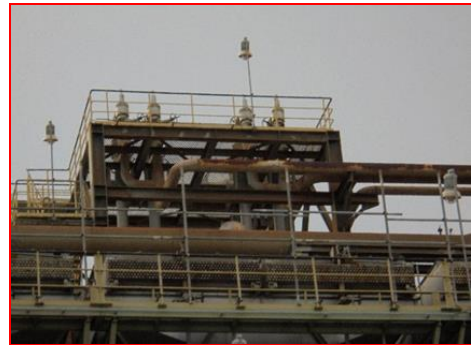
ภาพที่ 2.2-45 ระบบ Double Safety Relief Value
